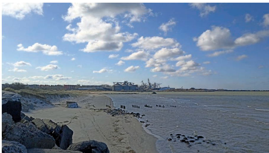
Figure 5. Emplacement du terminal d'exportation d'eau de Liepāja avec en arrière-plan les infrastructures existantes (2023)
