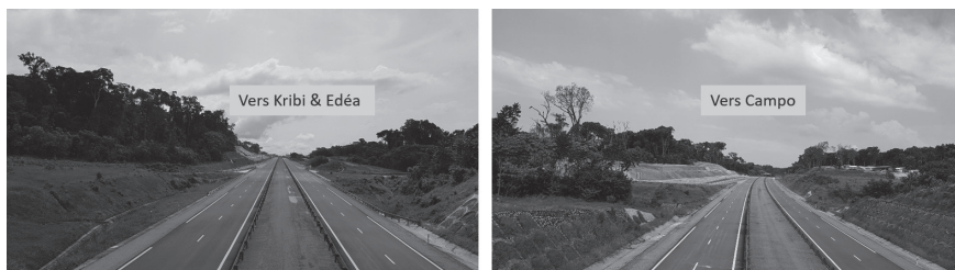
Figure 4 : Autoroute construite par les chinois de CHEC qui permettra de contourner la ville de Kribi pour connecter Edéa d'une part et Campo d'autre part
