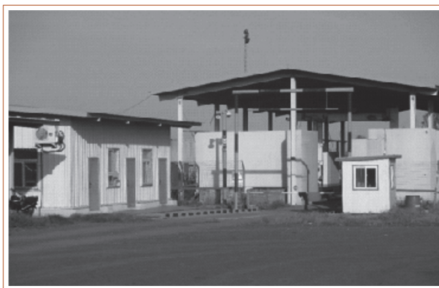
Photo 1 : Poste de scanner en zone sous douane réservé aux camions de marchandises en transit au port sec de Bobo-Inter
