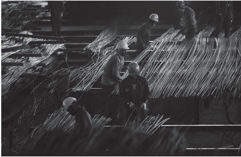
Photo 6 : Le fer à béton fabriqué au sein de la ZERP
