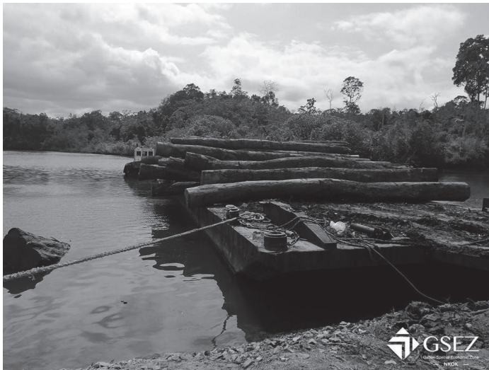
Photo 1 : Une barge accostée sur le site du futur quai fluvial de la ZERP
