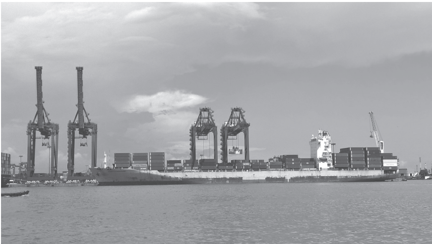
Figure 1 : TC1 à Abidjan : pionnier du développement conteneurisé portuaire du Golfe de Guinée dès 2004
