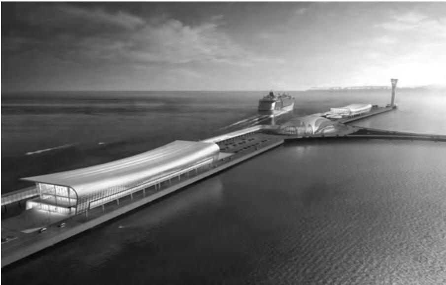
Figure 13 : Le futur terminal de croisière du port de Shanghai
