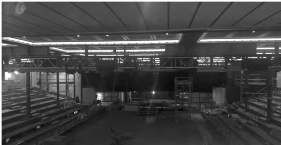
Figure 6 : La future patinoire en cours de construction sur les chantiers navals STX France
