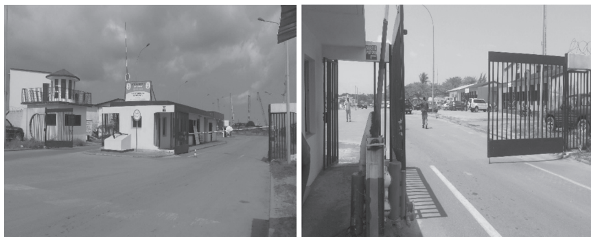
Figures 3 et 4 : L'entrée principale du port de Port-Gentil et son passage piéton
