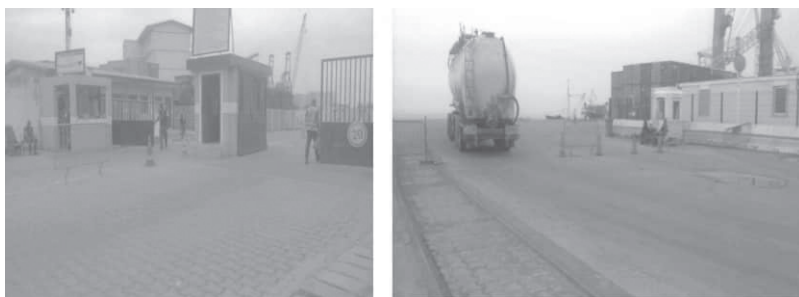
Figure 6 : Vue des postes de contrôle à l'entrée et au sein du quai GPM
