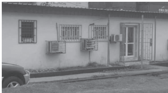
Figure 4 : Une vue des locaux de la Police de l'Air et des Frontières du PCO
