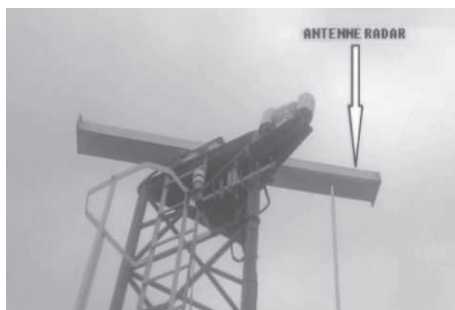
Figure 8 : Antenne du radar du PCO
